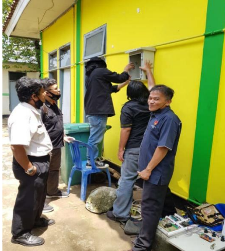
Gambar 6. Pemasangan Alat Pendeteksi Banjir
