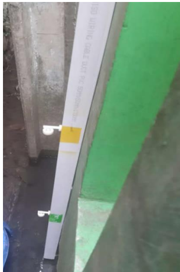
Gambar 7. Titik Lokasi Pemasangan Sensor Ketinggian Air
